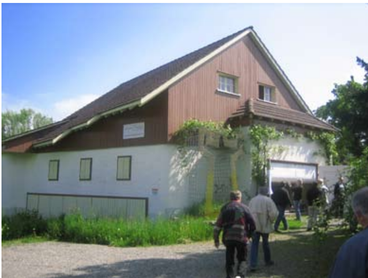
Dorfbunker in Bottighofen mit Tarnaufbau
