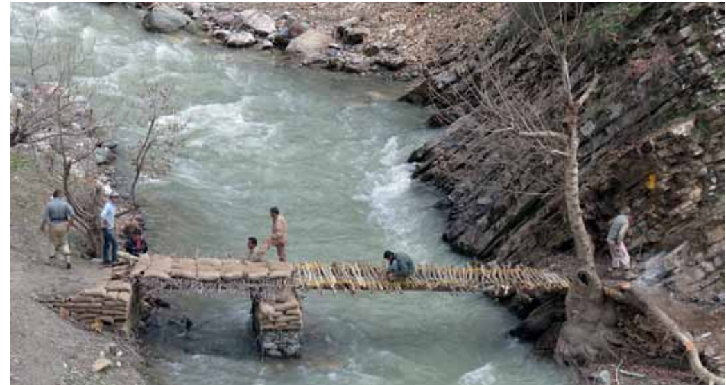
Instandstellung einer beschädigten Brücke in der Nähe von Rawanduz
