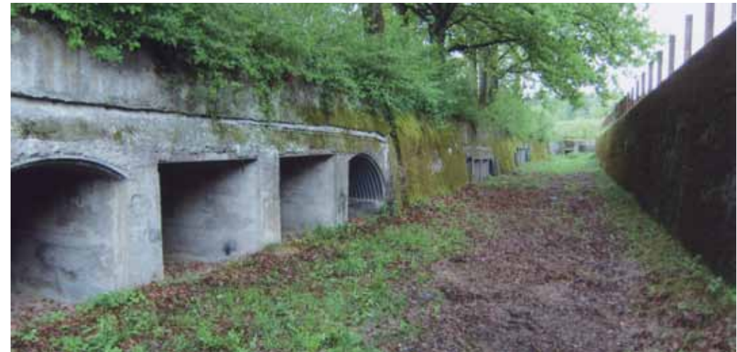
Der in den Panzergraben der Sperrstelle integrierte Kehlgraben des Stützpunkts Biberenäcker aus dem Ersten Weltkrieg
