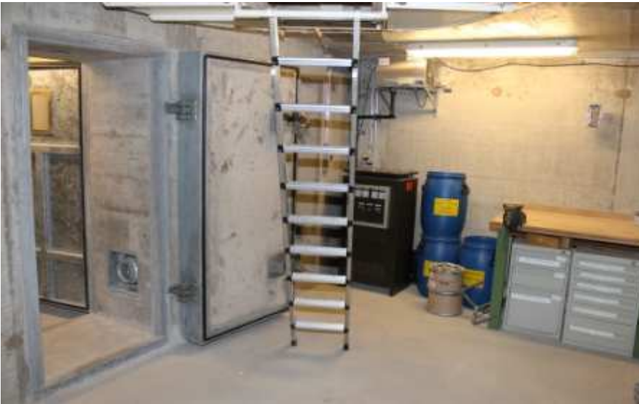
A 5583 Steighalten Nord, Laborierraum mit Eingang, Leiter zum Panzerturm und Werkbank
