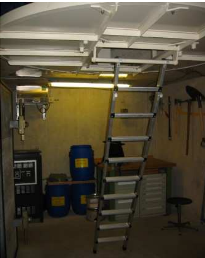
A 5578 Furtmüli Süd, Laborierraum mit Leiter zum Panzerturm und Werkbank
