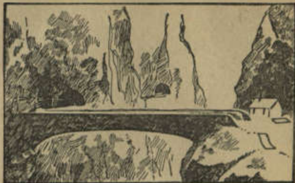
Die zur Sprengung vorbereitete Brücke
