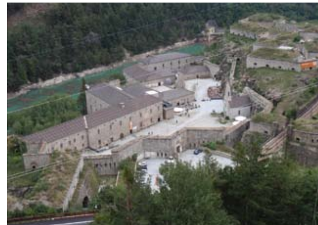
Aussicht vom Höhenwerk auf den unteren Teil der Franzensfeste
