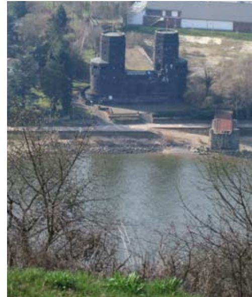
Von derselben Stelle aus gesehen wie auf der historischen Aufnahme: der stehen gebliebene Brückenpfeiler
