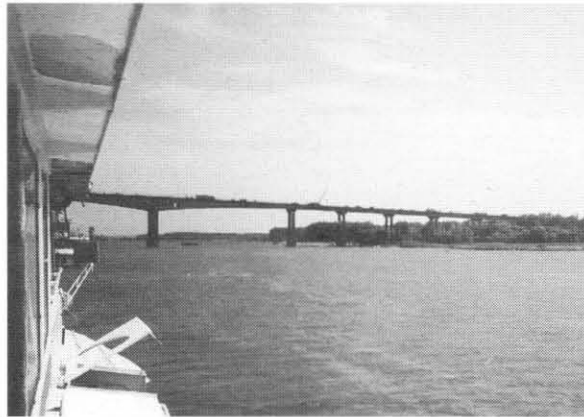
Der Don bei Rostow mit der neu erbauten Strassenbrücke
