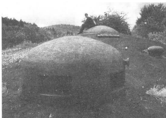
Der Geschützturm des Kampfblocks 14 des Werkes Hochwald-West
