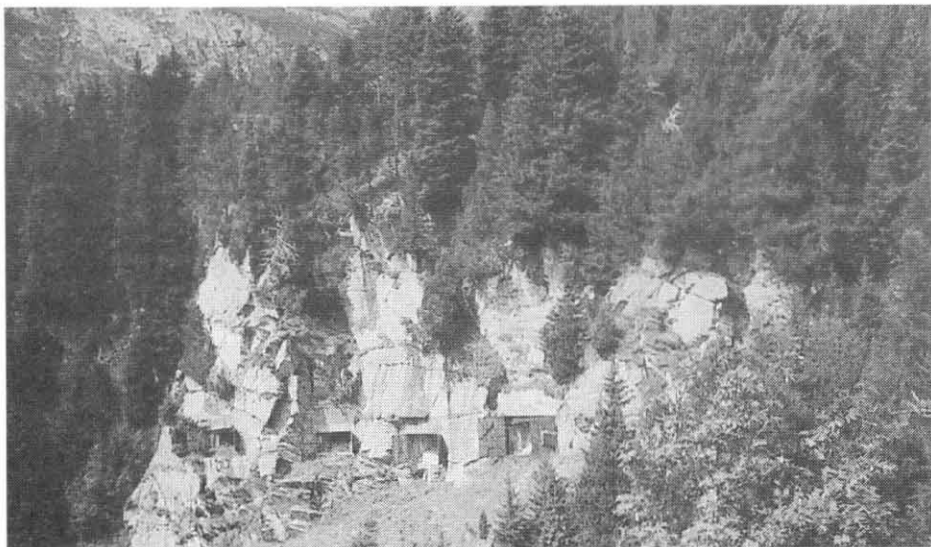
Nur dank der entfernten Tarnung sind die Scharten der Maloja-Stellung so gut sichtbar.
