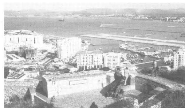
Der Aushub für die über 50 km langen Gänge im Innern des Felsens wurde auch zur Verlängerung der Flugpiste verwendet
