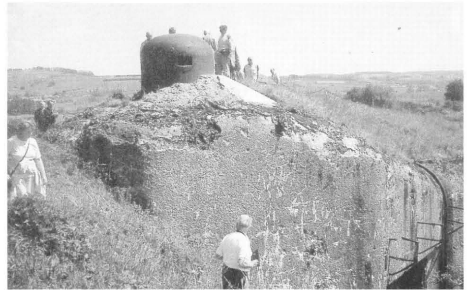
Der arg zerschossene Block 1 des petit ouvrage de La Ferté
