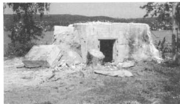
Der Abbruch des Lmg-Standes im Park des Hauses Neufeld in Zürich-Wollishofen
