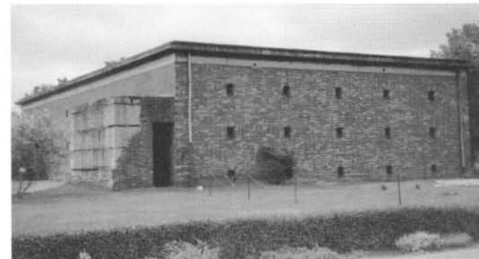
Der heute als Museum eingerichtete Befehlsbunker («Bunkerwarte»)
