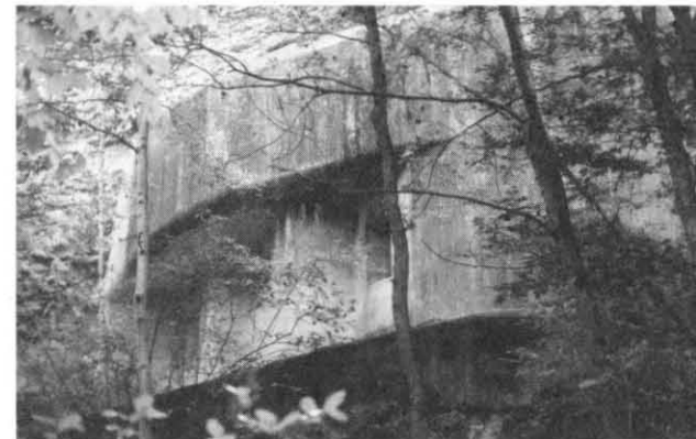
Das Infanteriewerk in der Sperre Magden-Enge wirkt 20 m über dem Boden aus einer unzugänglichen Felswand
