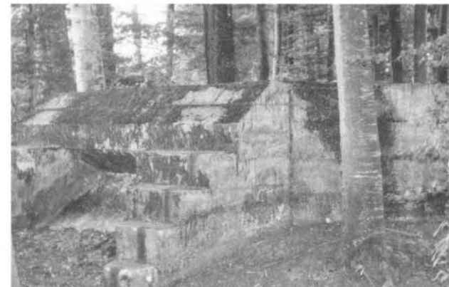
Verbunkerte 10,5 cm-Kanonen-Stellung bei Rüenberg
