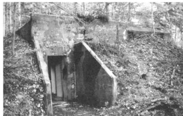
Bunker in der Armeestellung bei der Buuseregg
