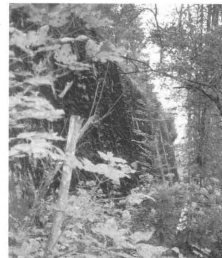
Die heute stark verwachsene, über 10 m hohe Panzermauer im Hünggi bei Unterägeri
