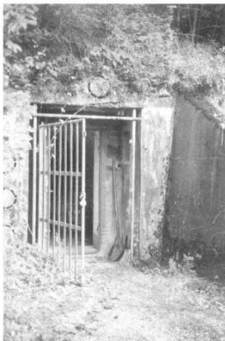
Der Eingang zur Kasematt-Batterie Stock an der Strasse zum Mostelberg
