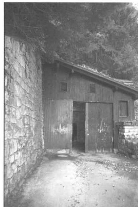
Haupteingang Werk Furgels
