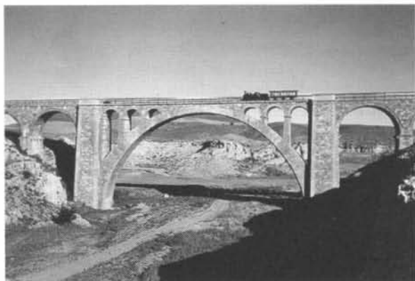
en passant: Alfambra Viadukt...
