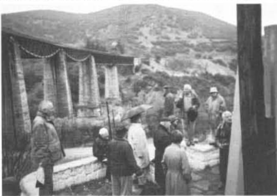
Eisenbahnviadukt über den Gorgopotamos
