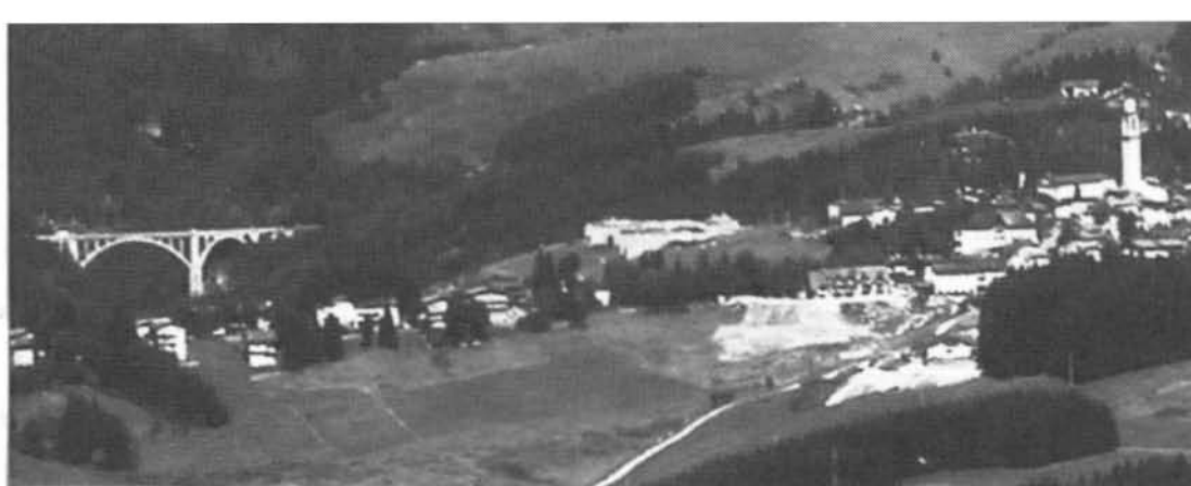
Blick vom Hang des Mte. Kaberlaba nach Nordwesten über den Mittelteil der Hochebene der Sieben Gemeinden auf den Ponte di Roana; dahinter ist zu erahnen der obere Teil des in der optischen Verkürzung harmlos wirkenden Assa-Grabens; rechts ist eine der Kirchen von Asiago mit dem für die ganze Gegend charakteristischen überhohen Turm zu sehen.
