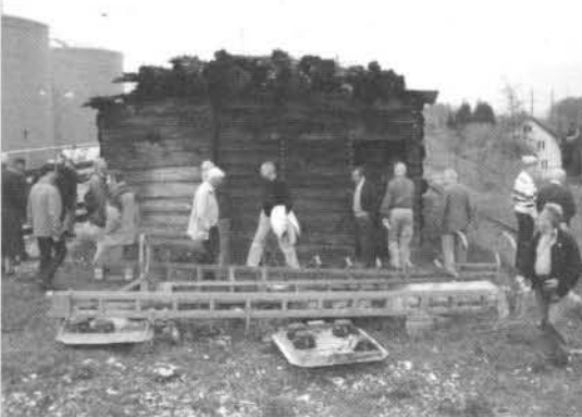
Getarnter Scheunenbunker Bahnhof Lengwil
