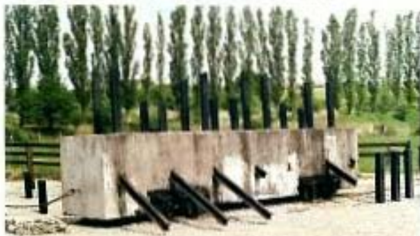
Das mit Eisenbahnschienen bestückte, bewegliche Beton-Panzerhindernis.
