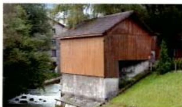
Mg-Bunker beim Bahnhof Ziegelbrücke
