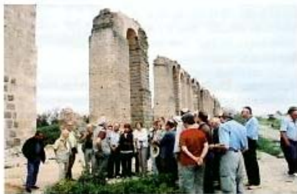
Reste des Aquäduktes (132 km lang), der Karthago mit Wasser versorgte (Uthina/Tunis)
