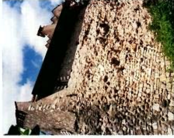
Römisches Mauerwerk am Kastell Altenburg (Brugg)
