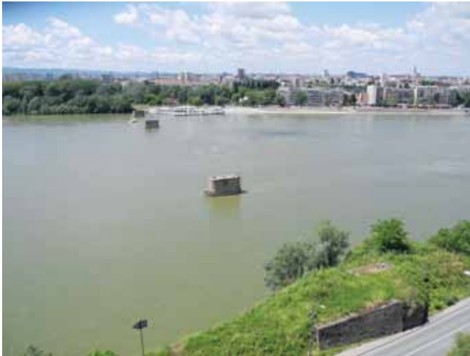
Novi Sad, Reste der durch die NATO 1999 zerstörten Donaubrücke
