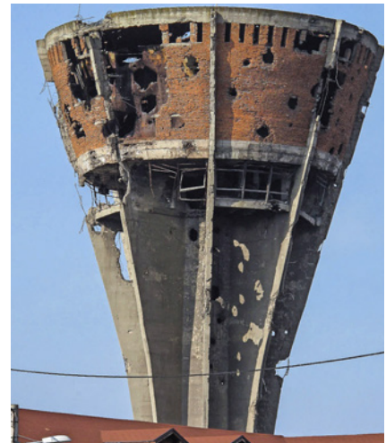
Wasserturm Vukovar (Bild: Internet)
