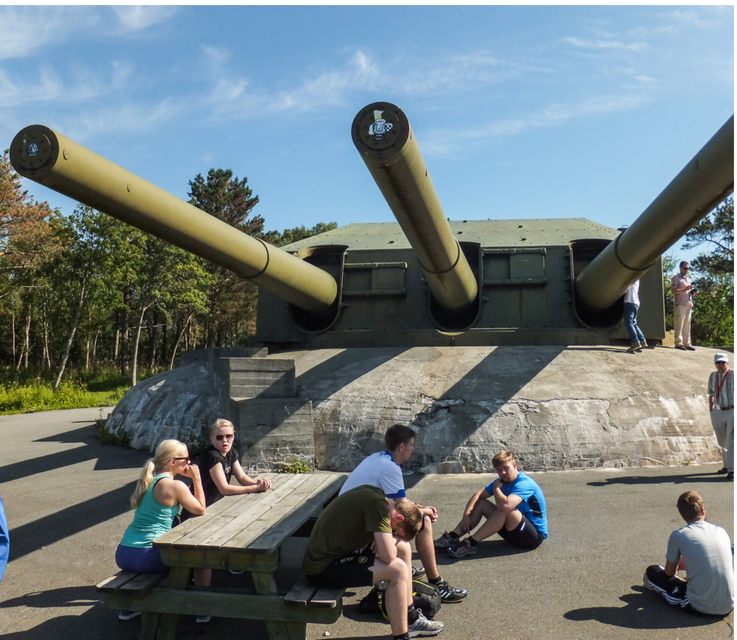
Der 28 cm Drillingsturmas der unbrauchbar beschädigten «Gneisenau» in Lundahaugen als Land-Festungswerk eingebaut
