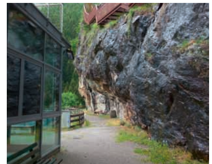
Eingangsbereich eines Vallo-Alpino-Bunkers in Moos im Passeiertal.
