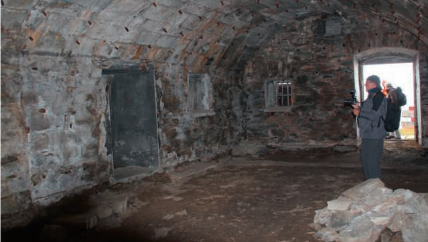
Gewölbe im Innern des Fort Stöckli
