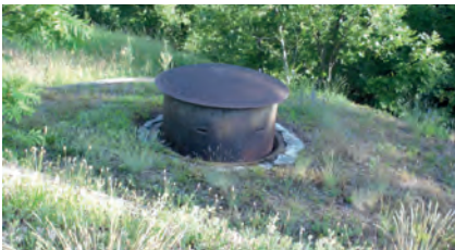
Batterie de Vulmix bei Bourg-St-Maurice, Typ Séré de Rivières, bis 1914 stark modernisiert
