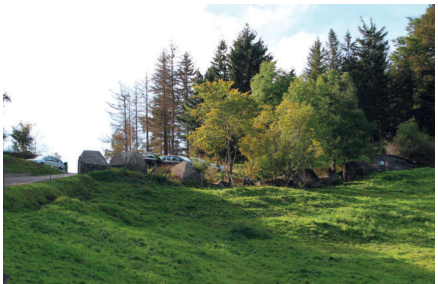
Geländepanzerhindernis (GPH) Chilchzimmersattel
