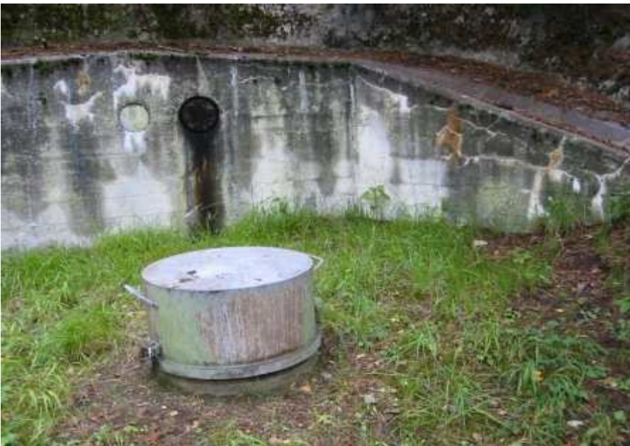
A 8717 Lumpegna, Felswerk, Abdeckhaube, Auspuff im Hintergrund
