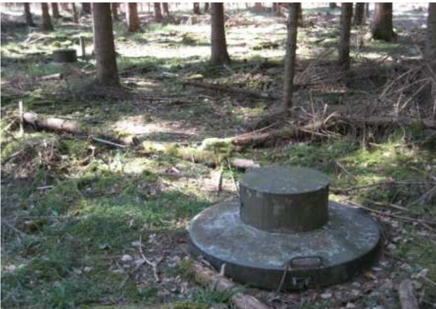
F 6525 Kyburgerstein, Abdeckhaube mit breitem Rand, Bau aus Fertigelementen, überwachsen mit Wald
