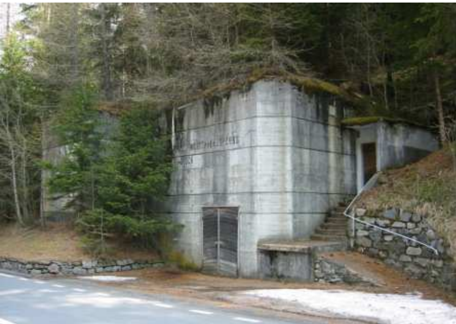
A 7616 Susch West, Monoblock getarnt als Wasserreservoir
