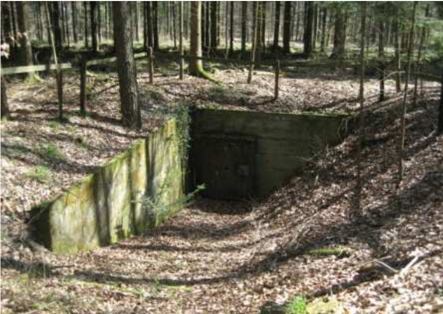
F 6525 Kyburgerstein, Eingangstüre, Bau aus Fertigelementen, überwachsen mit Wald
