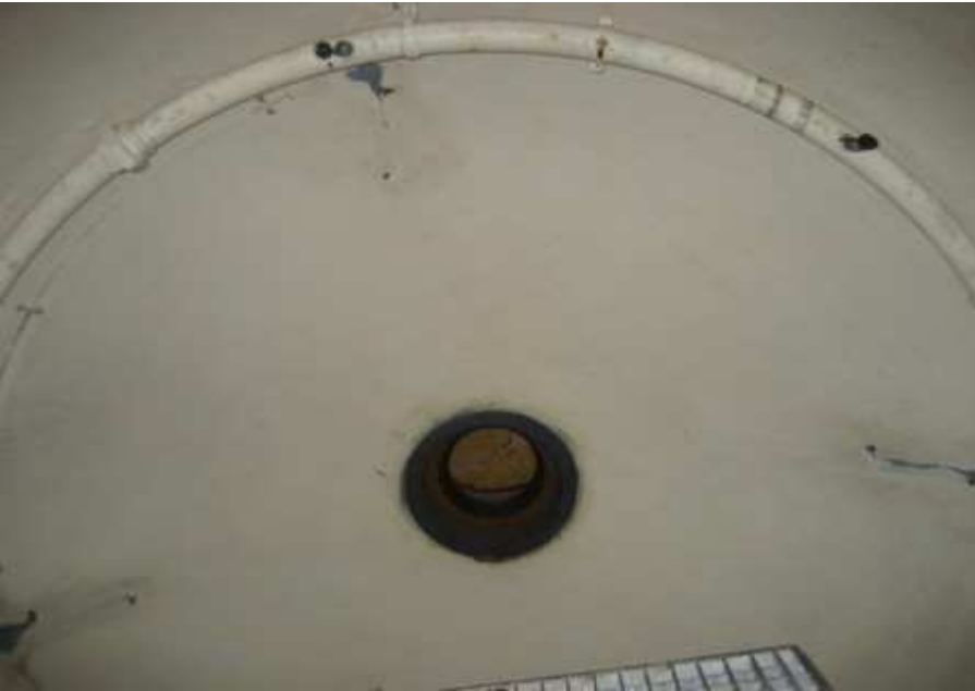
A 8146 Osogna, Loch in Kuppel für Kugelgelenk, Werfer demoniert
