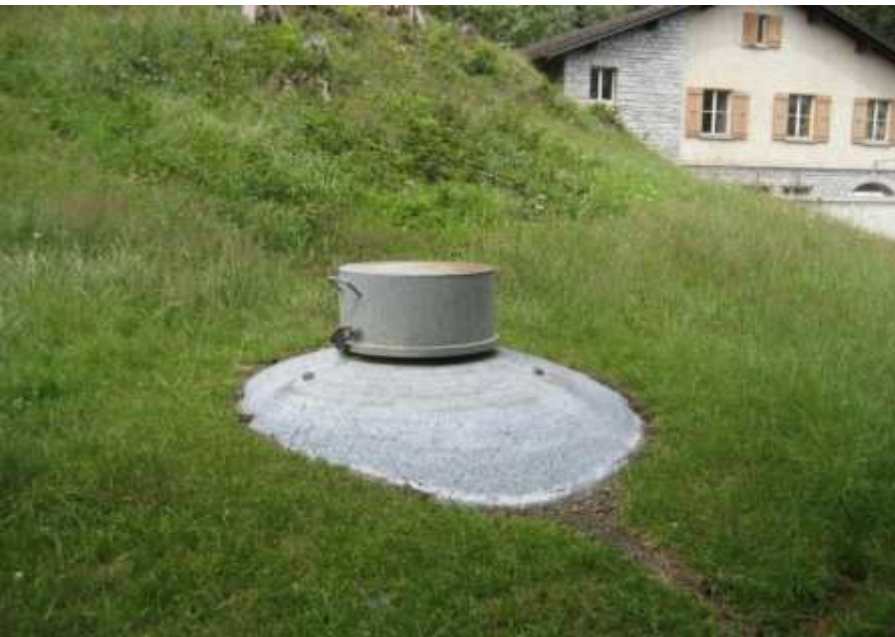
A 8314 Foppa 1, an Felswerk angebaut
