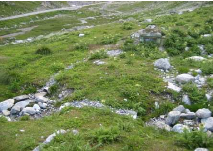
A 7756 Flüelapass, Scharten durch Metallplatten verschlossen und mit Steinen zugedeckt
