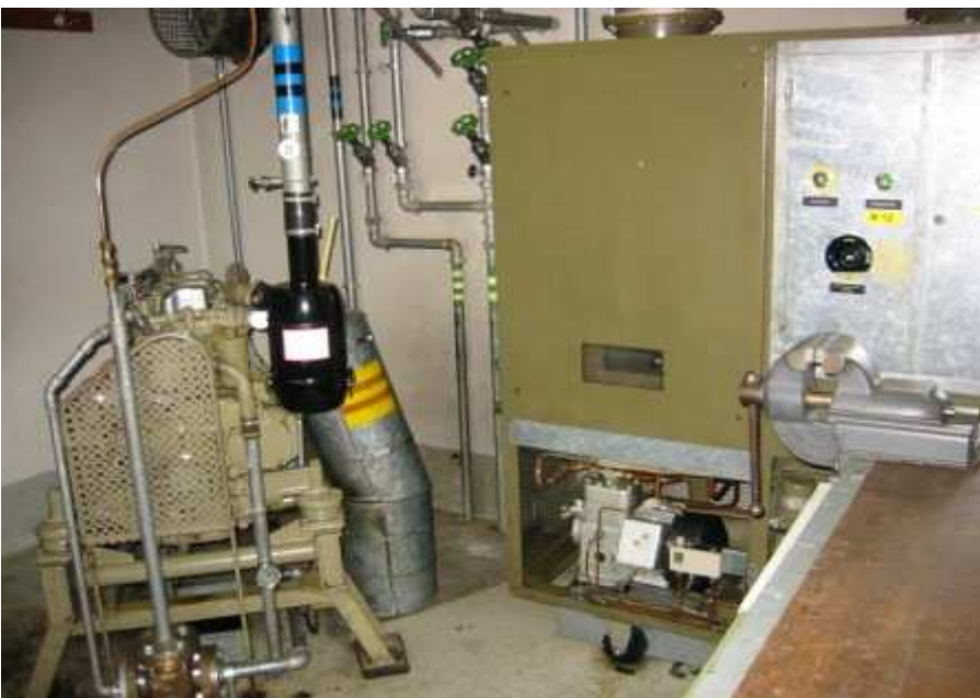
A 8717 Lumpegna, Felswerk, Maschinenraum
