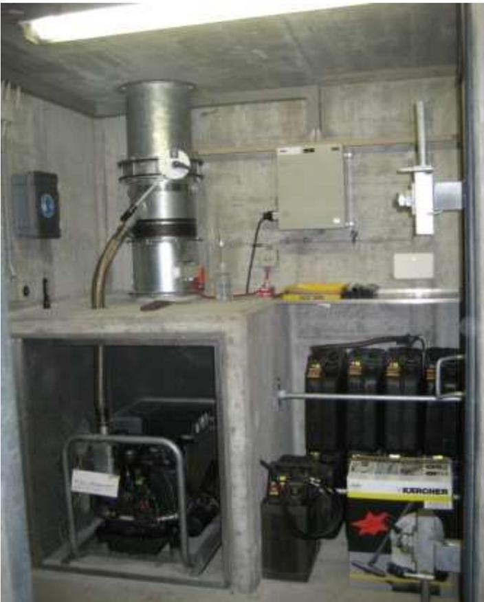
A 3835 Roost, Nische mit Notstromaggregat und Betriebsstofflager mit Kanistern
